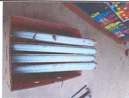
Foto 4: Se quitaron las lámparas anteriores que estaban defectosas ya que fueron instaladas en el año 2021, por lo que el sistema eléctrico ya necesitaba ser reemplazado.
