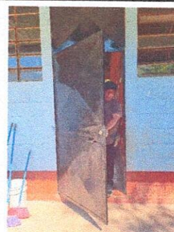
Foto 6: Se retiraron las puertas para realizar dicha reparación.
