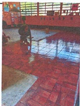
Foto 5: Se inició con la instalación del piso cerámico.
