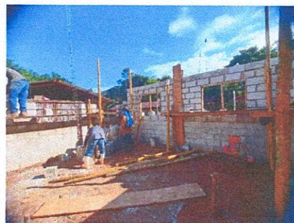
Foto 2: el levantamiento de paredes ya a avanzado, teniendo ya las ventanas.
